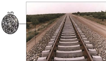
شکل ۱۱-۴: بالاست در زیرسازی جاده ریلی
