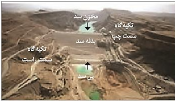
شکل ۴-۵. نمایی از بخش‌های مختلف یک سد
