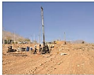
شکل ۴-۱ الف) مغزه‌گیری با گمانه‌های اکتشافی
