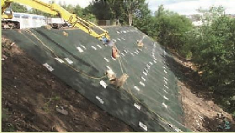
پایدارسازی شیب به روش میخ‌کوبی
